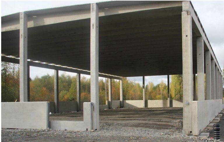
Kuva 4. Betonirakenteinen halli. Kuva Tom Lipkin.
