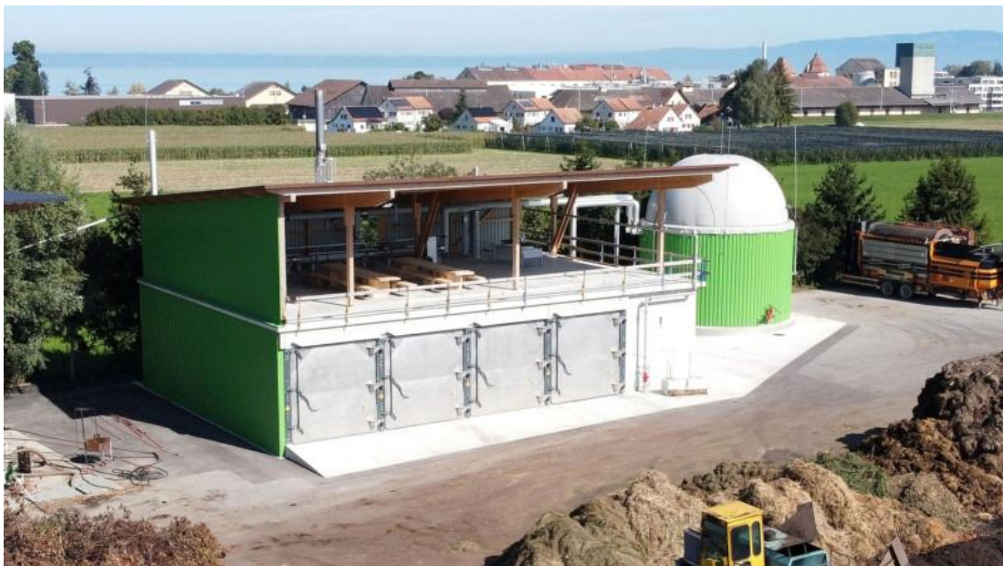
Kuva 18. Kuivamäädätyksessä käytettävä panosreaktori ja takana lietteen ja kaasunvarastointi (RENERGON RSD-S, kuva: Renergon International AG)
