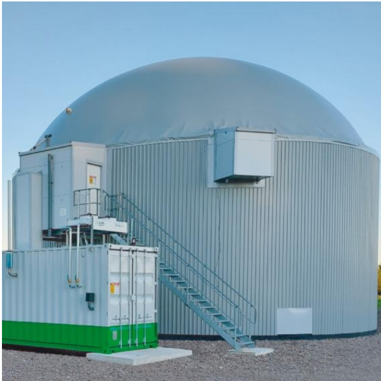
Kuva 17. Määdätyksessä käytettävä jatkuvatoiminen reaktori integroidulla kaksoismembraanikupolilla (Demeca gReactor, kuva: Hankkija Oy).
