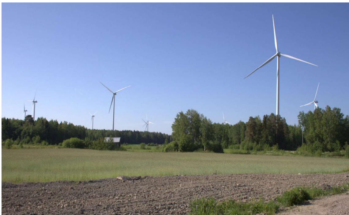
Kuva 2. Tuulivoimapuisto Pohjanmaalla (Jan Nyman, 2025).
