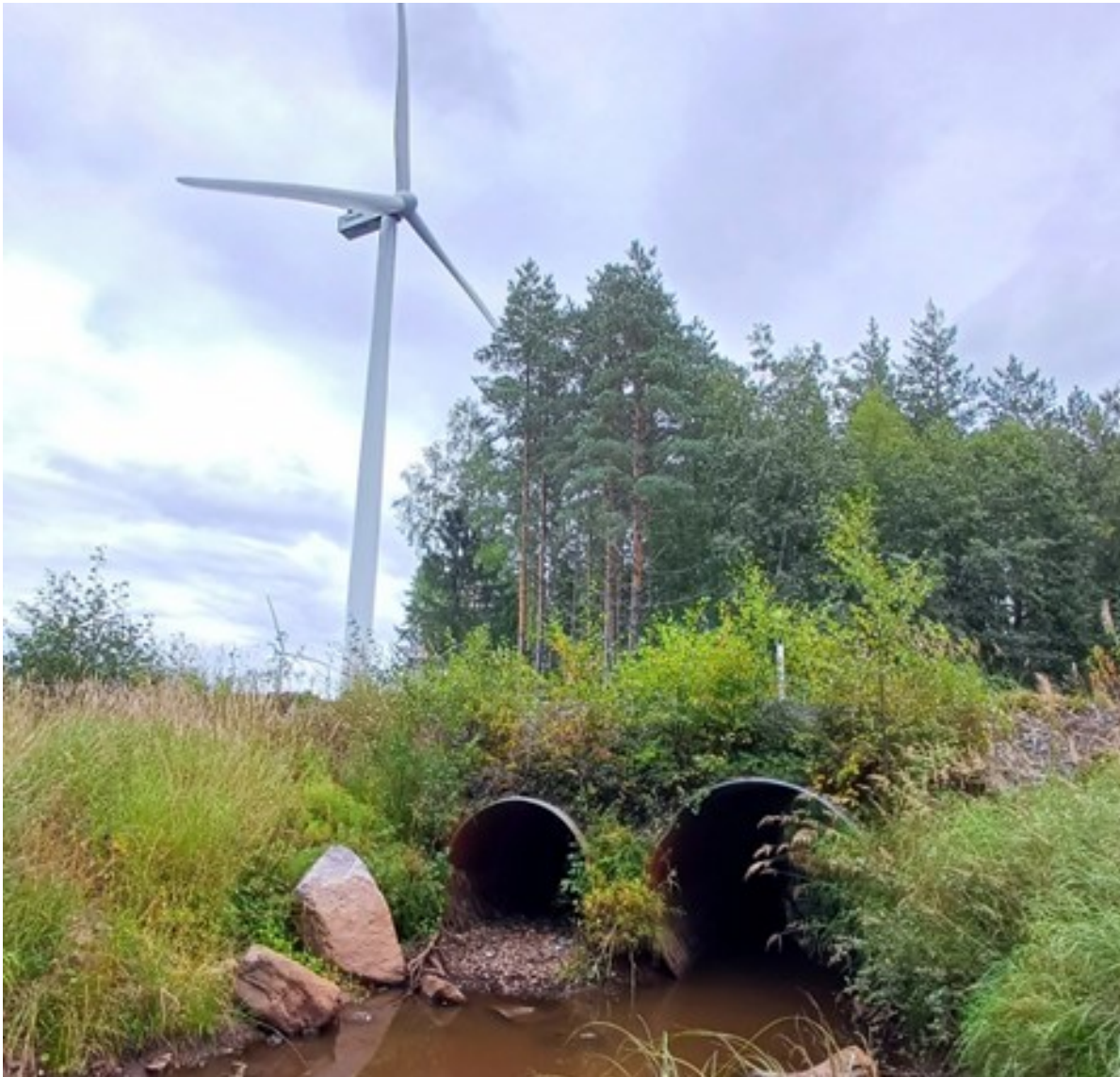
Kuva 10. Tuulivoimalan läheisyydessä oleva oja, jonka ylitse kulkee huoltotie. Tierummut ohjaavat veden kulkua. (Kropsu ym. 2025, kansikuva.)
