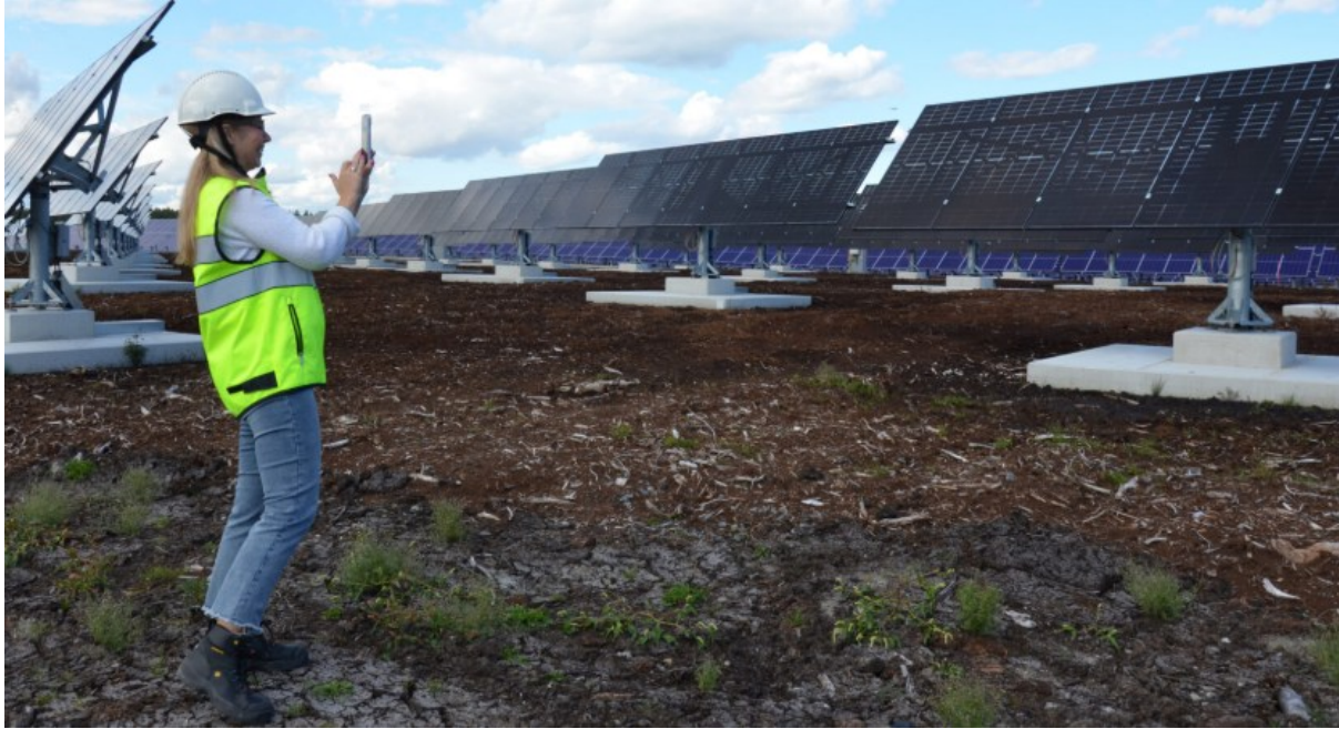
Kuva 7. Lapuan Heininevalle rakennettu aurinkovoimahanke (Heininevan aurinkovoimapuiston kaikki paneelit on asennettu – katso video puiston valmistumisesta, 2025).
